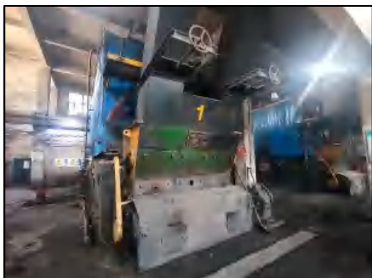
风井场地 2 台 7MW 燃煤锅炉
