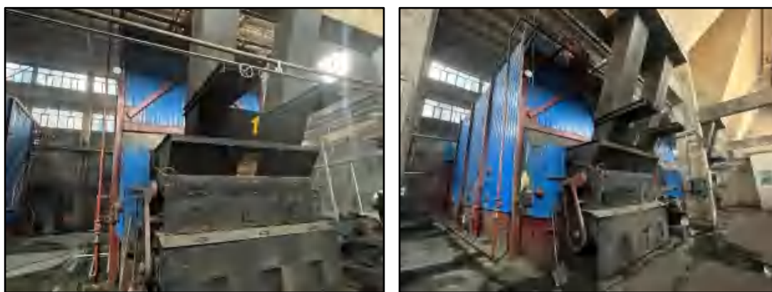
主井工业场地 2 台 14MW 燃煤热水锅炉
