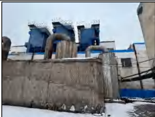
主井工业场地燃煤锅炉除尘器和脱硫塔
