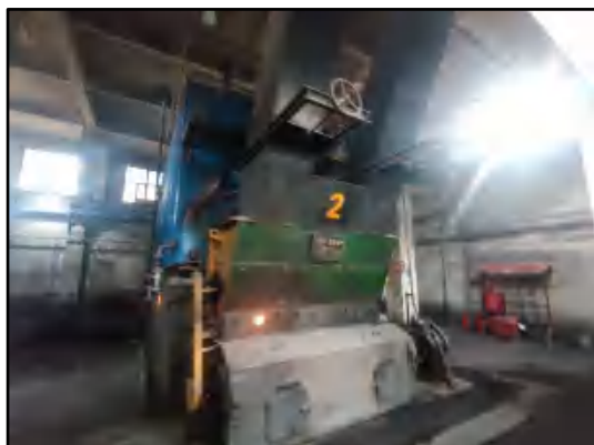
风井场地 2 台 7MW 燃煤锅炉
