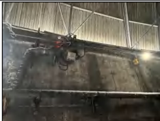
全封闭原煤仓喷淋降尘抑尘设施
