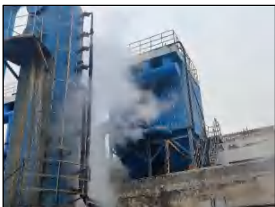
风井场地燃煤锅炉除尘器
